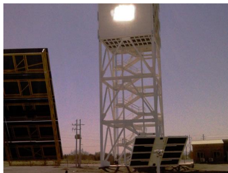
Figura 1. Campo de helióstatos (UNISON)
